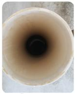
หลังจากนำไส้กรองเก่าออกมาแล้ว ให้ทำความสะอาดเศษตะกอนที่ ค้างอย่ในกระบอกไส้กรอง
