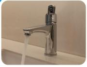
เปิดน้ำหึ้ง(จากก๊อกน้ำตำแหน่งที่ไกล สุด)เพื่อลดแรงดันน้ำในเครื่องกรองน้ำ (เปิดจนน้ำหยุดไหล)
